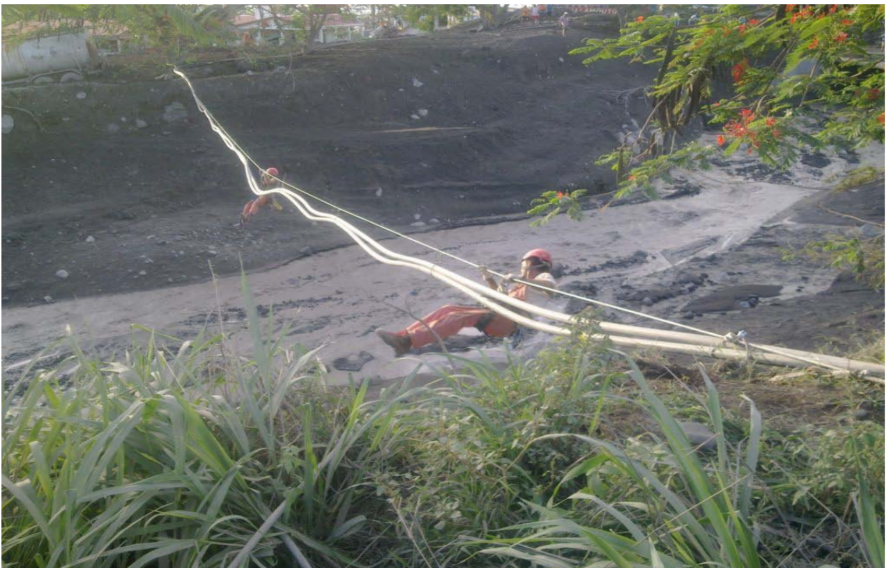
Mise en place de deux conduites de PE 63 sur un câble métallique pour la traversée de la rivière : travaux acrobatiques réalisés par les équipes spécialisés de CAN S.A.
