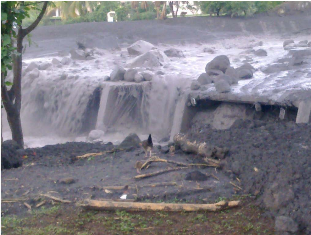
Coulées de boues sur le pont des Abymes provoquant la rupture de la canalisation passant en encorbellement.
