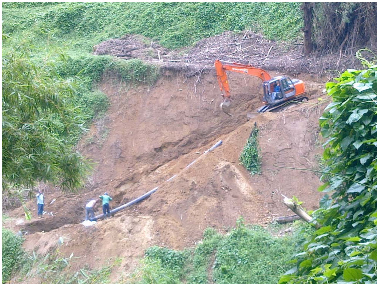
Mise en place de la canalisation PE 200 à travers la forêt sur le territoire du MORNE-ROUGE : travaux réalisés par les équipes de la SME
