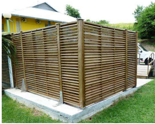
Photo 9 : PR VVF EDF
