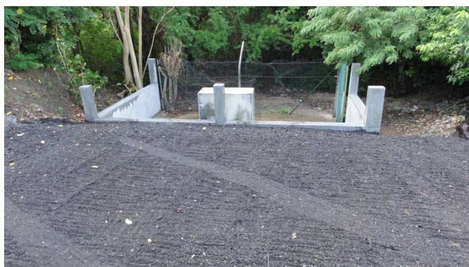
Photo 13 : Reprise du PR Pierre et Vacances (travaux en cours)
