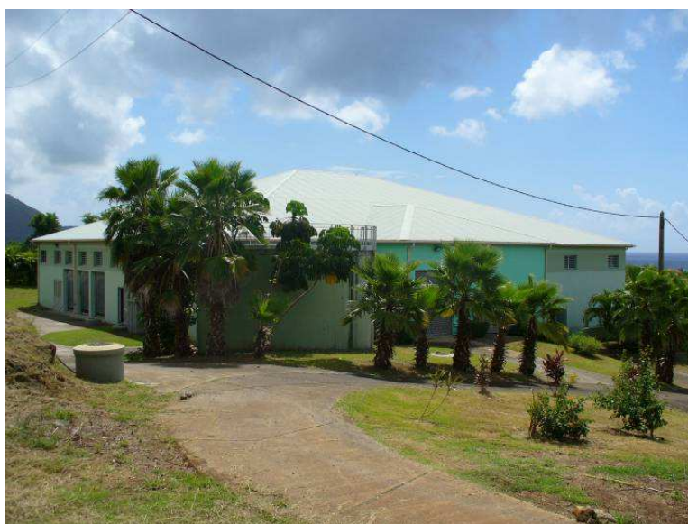
Photo 15 : Station de Gros Raisins
