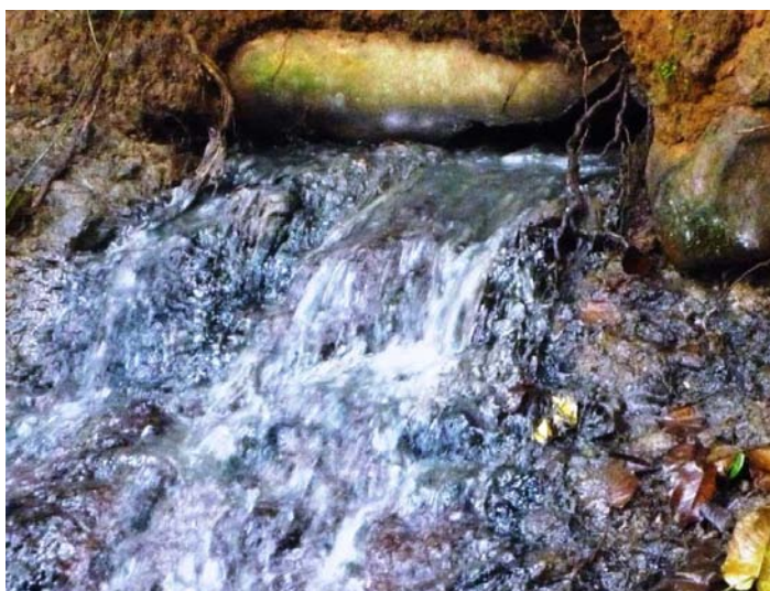
Photo 3 : Rupture de réseau de collecte en amiante ciment (Rivière Pierre)
