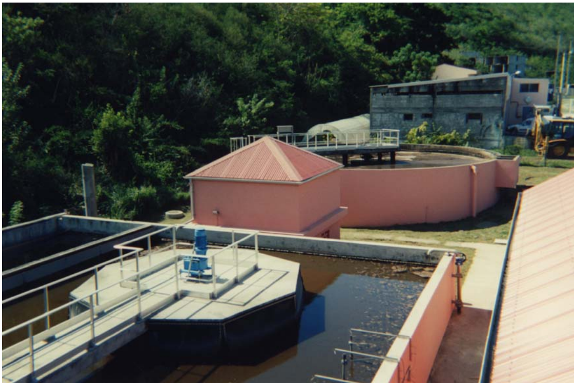
Station de Traitement d'eaux usées du bourg.
