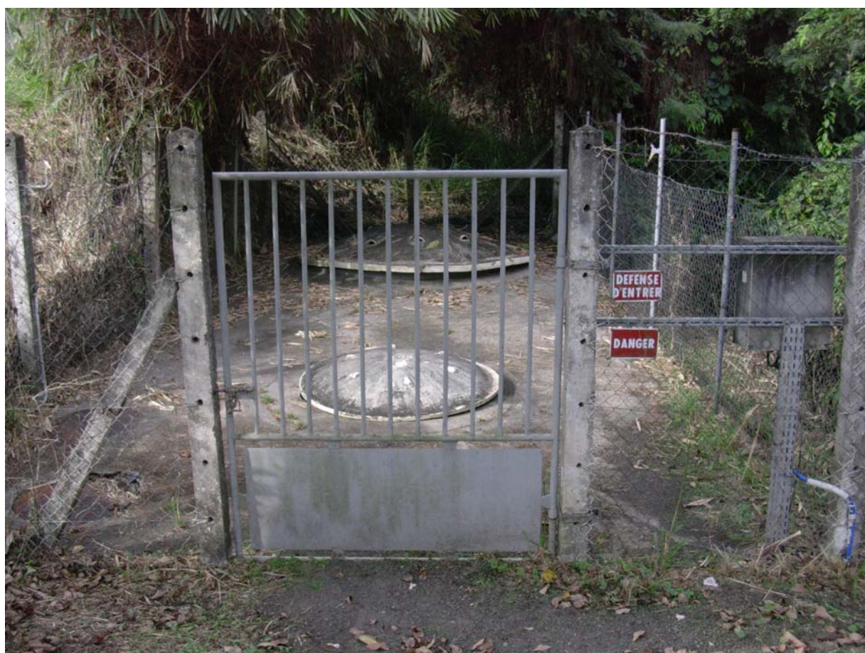
Station de traitement d'eaux usées La Vigie (ancienne)
