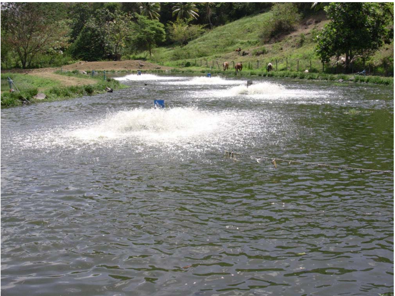
Station de traitement du bourg.
