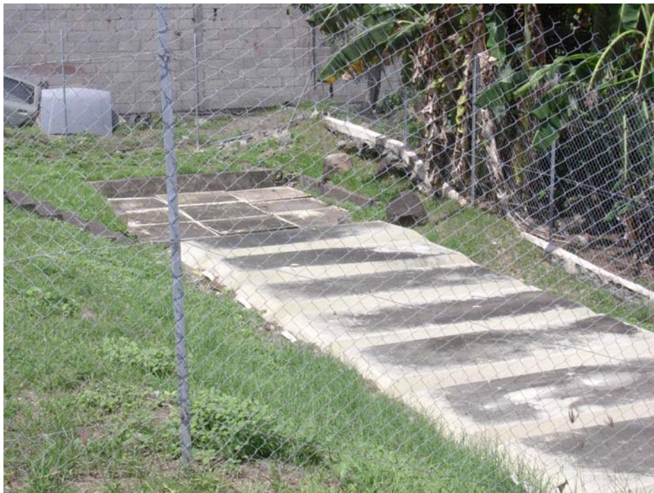
Station de type décanteur digesteur d'une capacité équivalente à 150 éq.hab. Arrivée des effluents : gravitaire.
