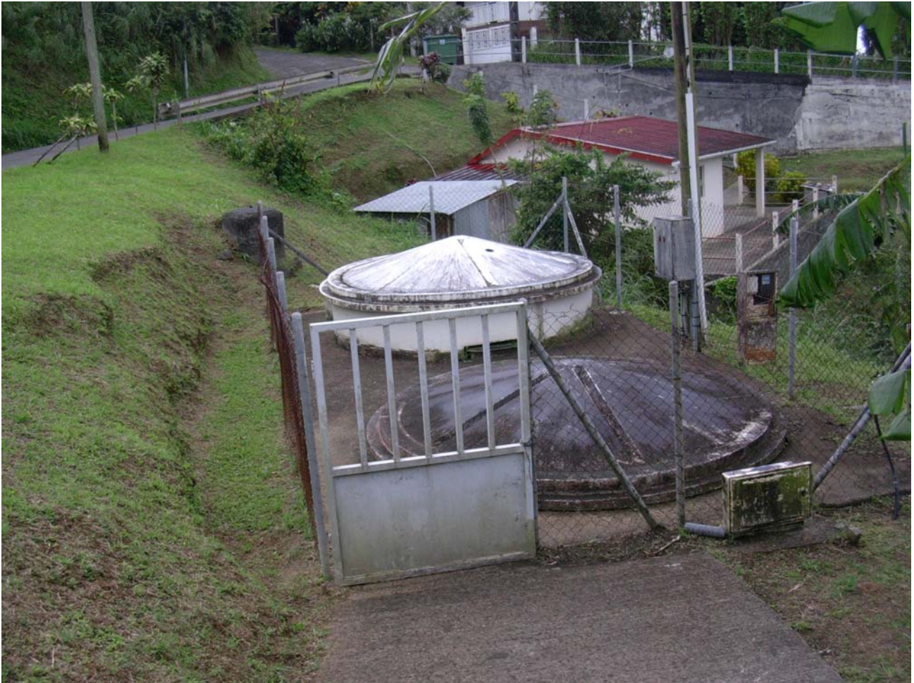
Cette station d'épuration OXYVOR de type boues faible charge, à capacité nominale équivalente à 100 éq
