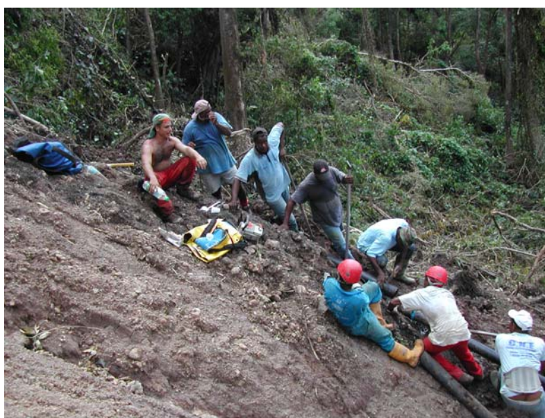
Réparation de l'adduction d'Attila sur les flancs des Pitons du Carbet
