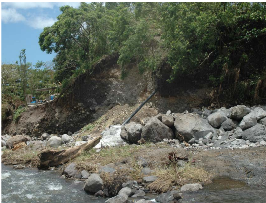
La conduite est dans le vide et reste à la merci d'une crue
