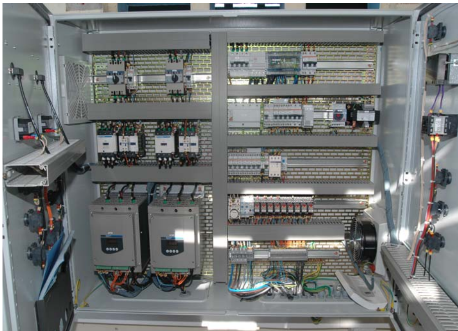
Nouvelle armoire électrique de MANIBA intégrant des démarreurs progressifs
