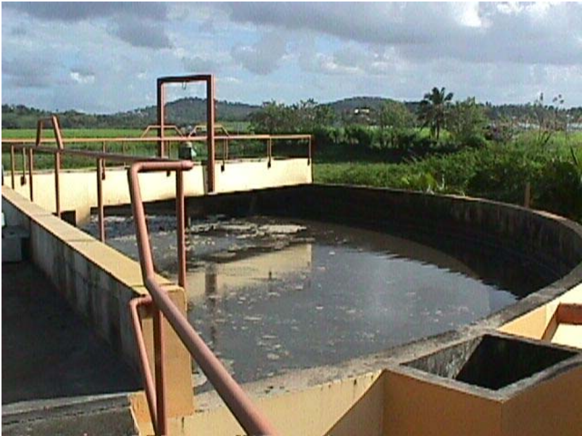
STATION DE TRAITEMENT D'EAUX USEES DU BOURG. -BASSIN D'AERATION -
