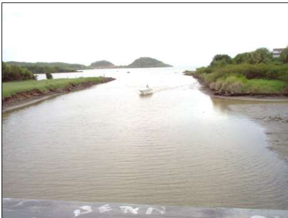
embouchure du canal du François à marée basse (photo DIREN 10/05/2005): le canal est très envasé, le tirant d'eau est faible, les pêcheurs ont dû mal à naviguer.
