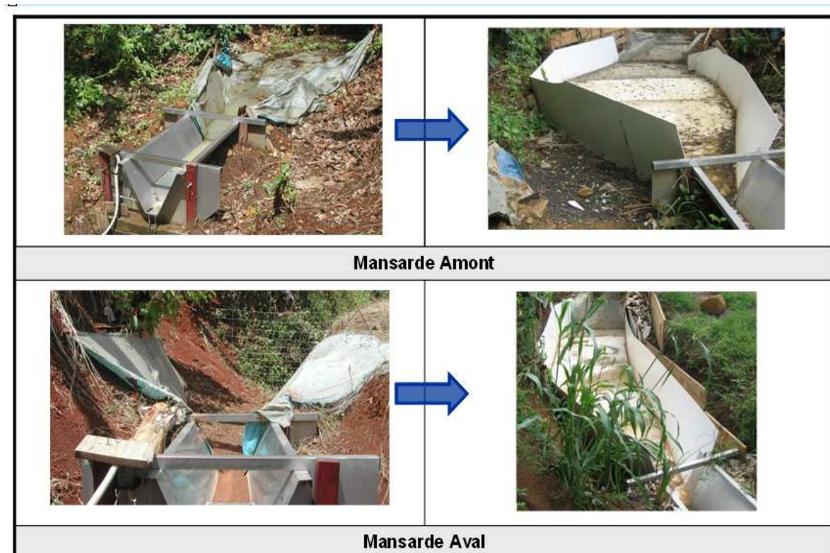
Photos 8 à 11 : Canalisation en amont des canaux Venturi
