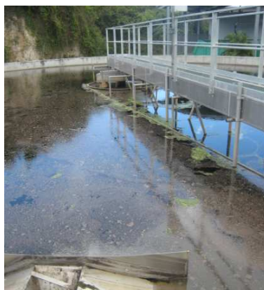
Figure 18 : STEP du Marin, Guadeloupe, possibles traces de rejets non conformes dans le clarificateur Photo : N. Richez
