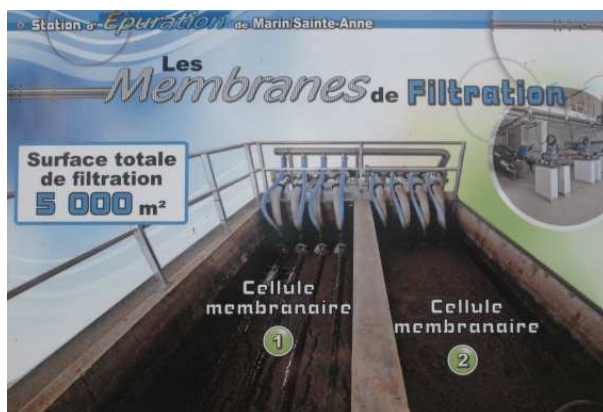
Figure 12 : Bioréacteur à membranes de la STEP du Marin, Martinique Photo : N. Richez
