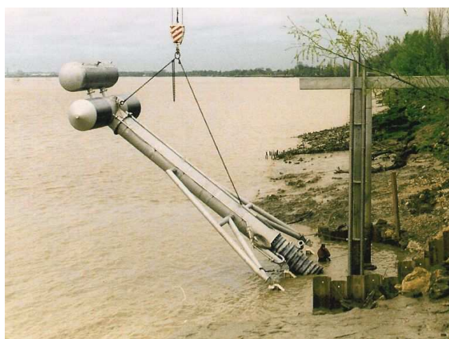
Figure 29. Mât oscillant en phase de mise en place au Bec d'Ambes en Gironde
