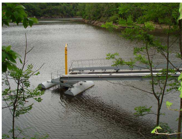
Figure 29. Mât oscillant en phase de mise en place au Bec d'Ambes en Gironde
