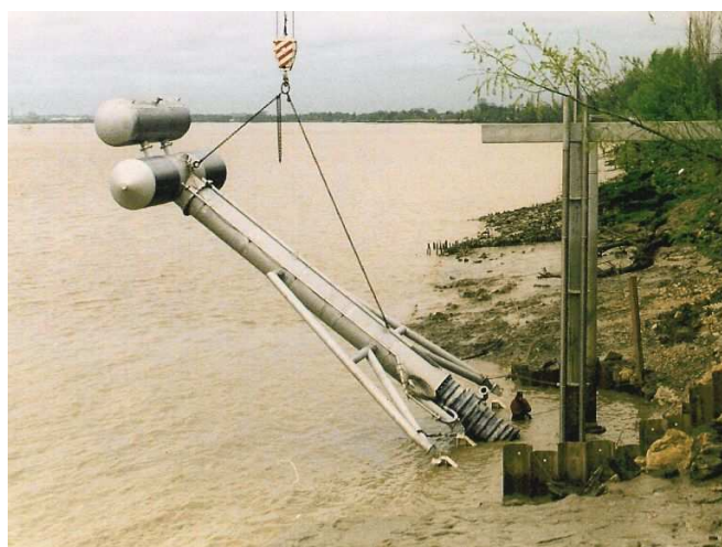
Figure 23. Mât oscillant en phase de mise en place au Bec d'Ambes en Gironde
