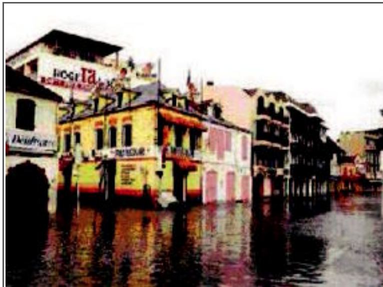
Illustration 8: Inondation pluviale – Fort-de-France, cyclone Luis 1995 (Source : Météo France)
