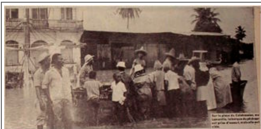
Illustration 20: Inondations au Lamentin lors du cyclone Dorothy en août 1970 (source : PPRN Lamentin)
