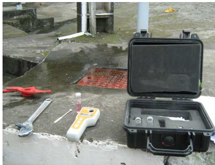
Figure 38 : Test de chloration
