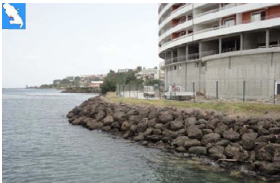
Illustration 20 : Enrochements au niveau de la construction d'un immeuble (Pointe Simon - Ville de Fort de France). Source : Paulineau M. (2012)
