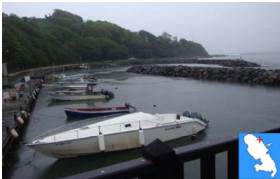
Illustration 23 : Ouvrage portuaire au niveau de la ville du Marigot. Le port est ici constitué de deux digues en enrochements. Source : Paulineau M. (2012)
