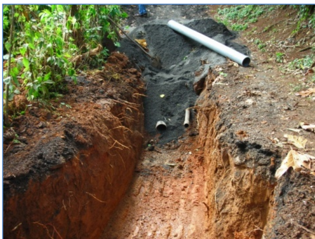
Photo 1. Travaux d'extension de réseau (gravitaire et refoulement)
