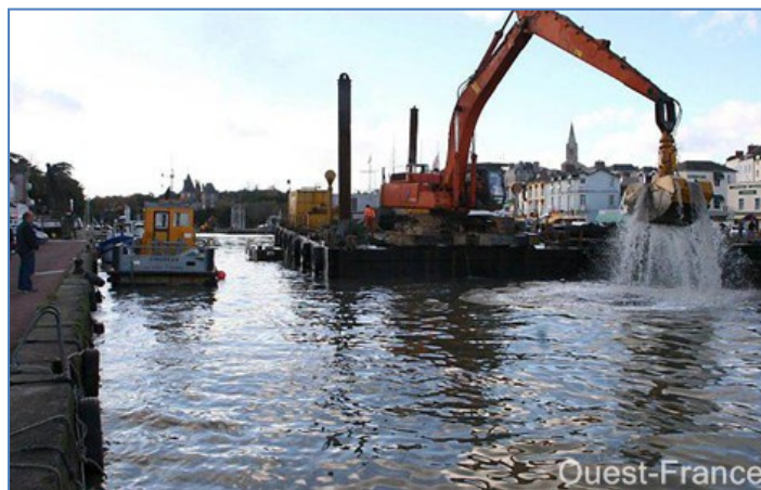
Photo 8. Désenvasement d'un port en Loire-Atlantique
