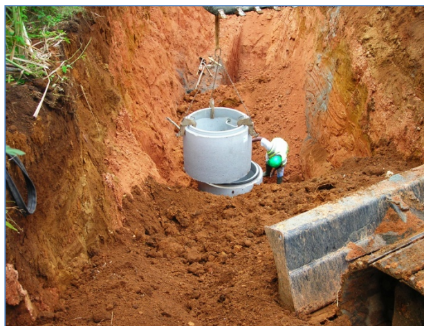
Photo 2. Pose de regard
