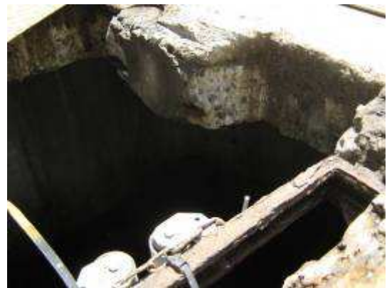
PR Pavillon – corrosion des trappes et usure du Génie-civil
