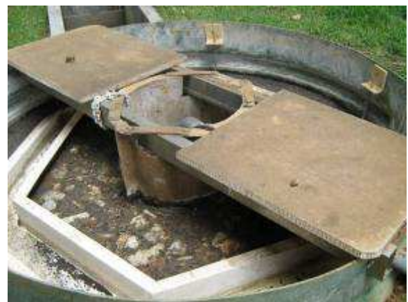
STEP Baignoire à Marigot – Absence de boues dans le bassin biologique et boues au niveau du clarificateur
