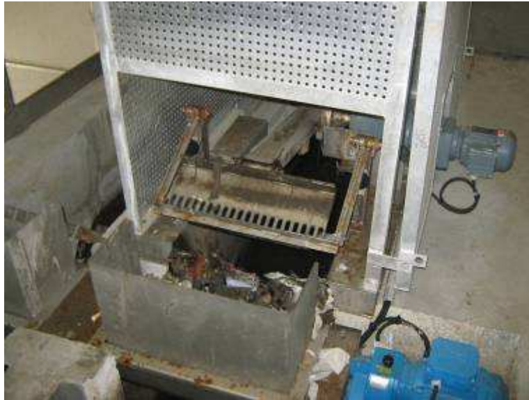
STEP Pointe Bénie – Traces de corrosion - Dégrilleur
