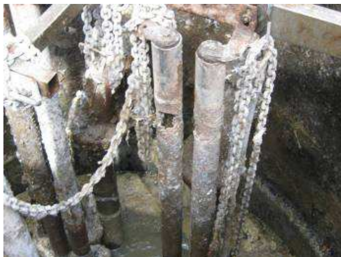
PR Seguineau – Corrosion des barres de guidage
