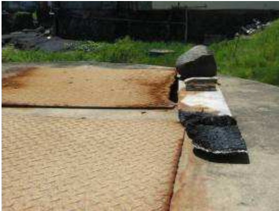
PR Pavillon – corrosion des trappes et usure du Génie-civil
