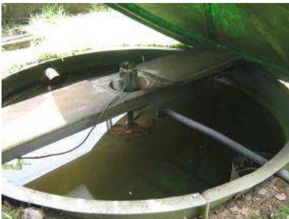
STEP Baignoire à Marigot – Absence de boues dans le bassin biologique et boues au niveau du clarificateur
