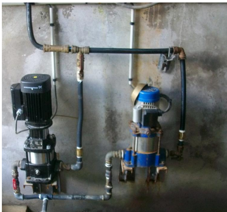
Remplacement clapets et pompe de recirculation réservoir Chamflor
