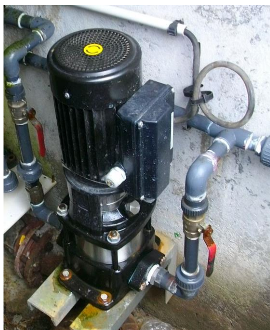
Mise en place nouvelle de recirculation Réservoir Brise Charge
