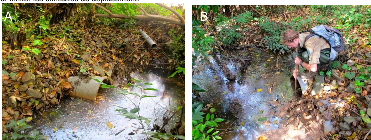
Figure 39 : Photographies prises sur le terrain de la sortie nord-est des buses (A) et mesure de suivi de la hauteur d'eau au niveau des buses nord est (B), (Impact Mer)
