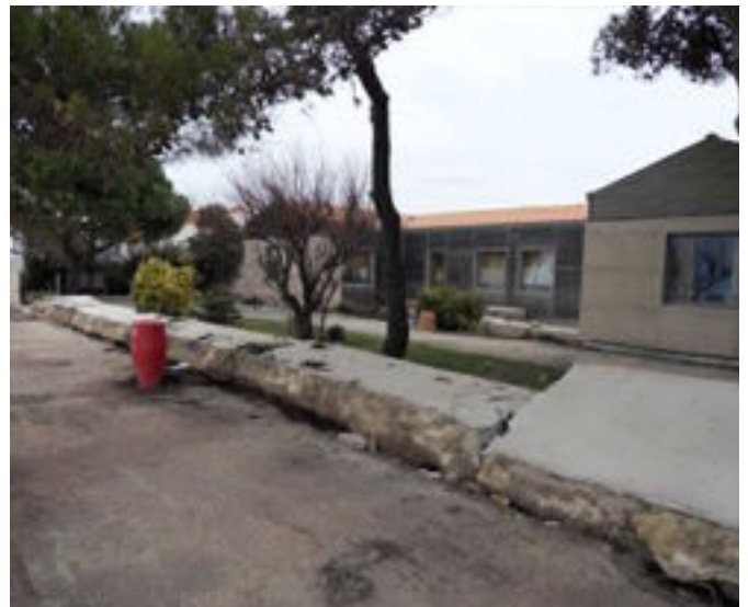
Illustration 30 : Effets des chocs de vagues à Fouras (17) lors de la tempête Xynthia (Source : ARTELIA)
