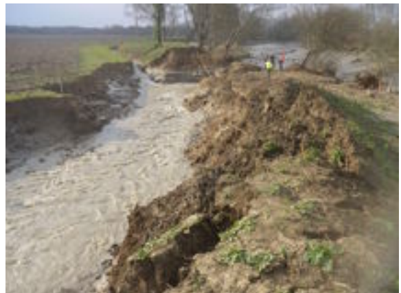
Illustration 29 : Brèches dans le cordon dunaire de la Dune d'Aval à Wissant (62) le 26 février 1990 (Photo : Olivier Beaulieu) et dans une digue de l'estuaire de la Gironde (Photo : groupe Géotechnique, Risques et Bâtiments du LRPC de Bordeaux – 4 mars 2010)
