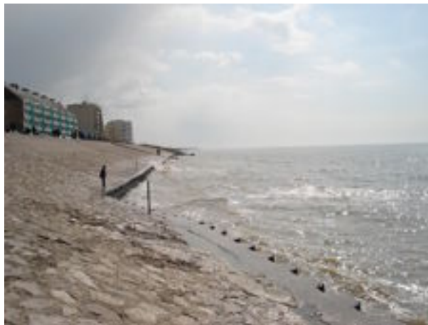
Illustration 8 : Perré à Wimereux (62) s'étant substitué au trait de côte (Photo : CETMEF)
