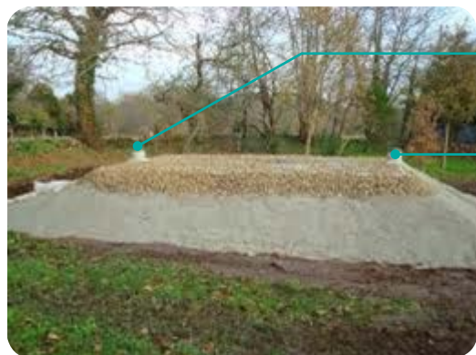
Photo d'un tertre d'infiltration non drainé
