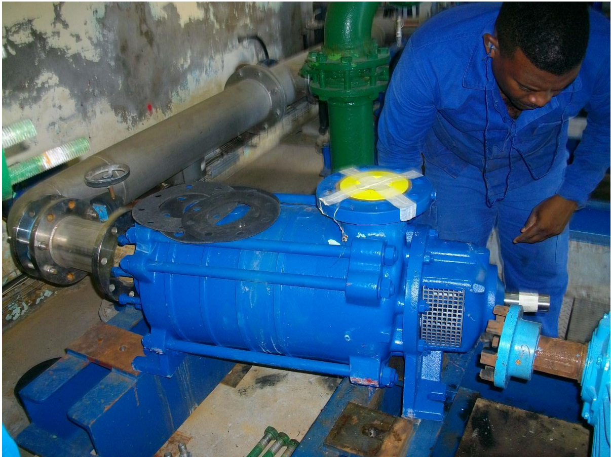
Montage de la seconde pompe de refoulement vers Dominante de l'UPEP du Lorrain
