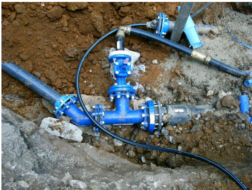
Raccordement de la caanlisation DN 200 de Rivière Pomme à la distribution du réservoir Vert Pré3
