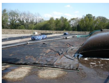
Remplissage des boudins géotextile
