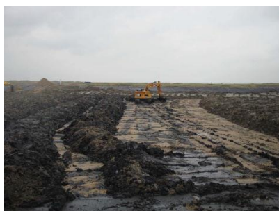
Mise en andains des sédiments dans la lagune
