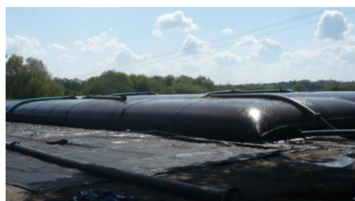
Remplissage des boudins géotextile
