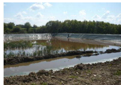
Remplissage du bassin de décantation des eaux
