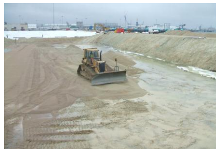
Aménagement du casier (géomembrane, drains horizontaux, couche de sable)
