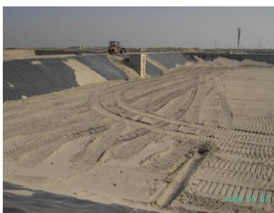
Construction du bassin (imperméabilisation, drainage)
