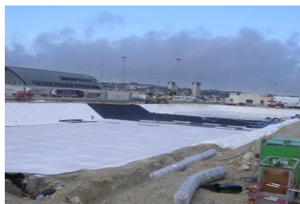
Aménagement du casier (géomembrane, drains horizontaux, couche de sable)
