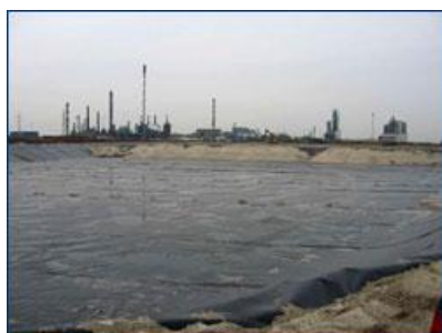
Construction du bassin (imperméabilisation, drainage)
