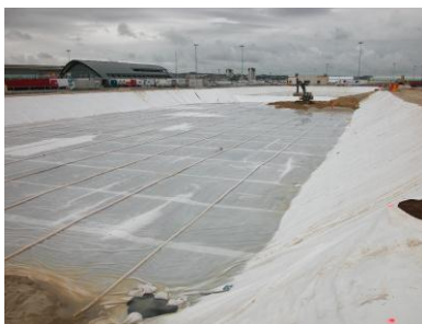
Aménagement du casier (géomembrane, drains horizontaux, couche de sable)
