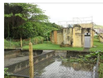
Station d'épuration de Petit Bac – Au premier plan, les cuves de séchage des boues
