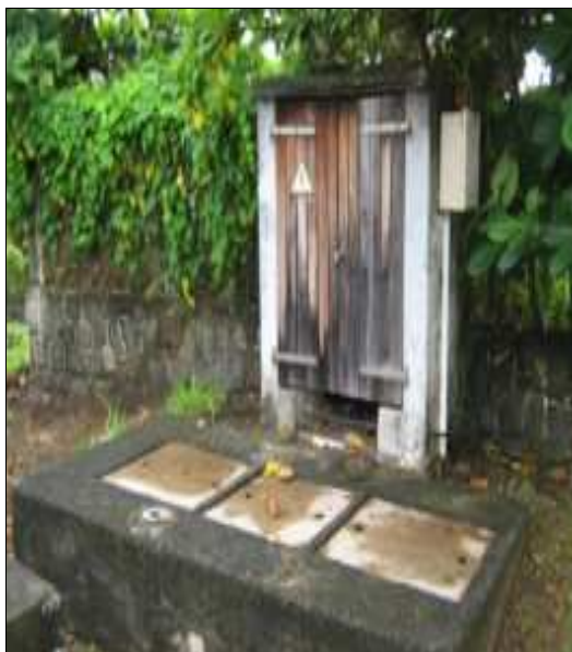
vue d'ensemble: pas de protection du PR
