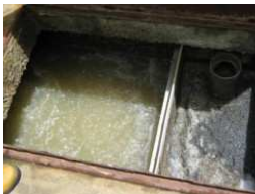
Dessablage/degraissage
