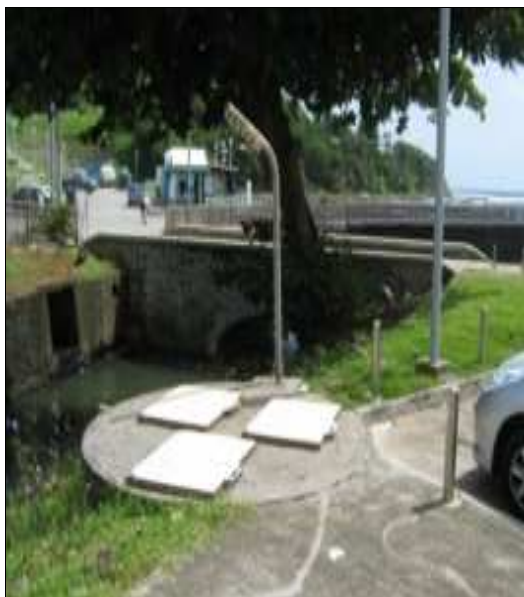
vue d'ensemble: PR non clôturé
