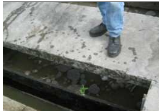
dégraissage/dessablage: état et absence de protection
