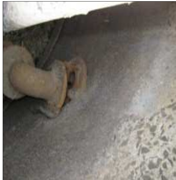
Refoulement cassé et rouille
