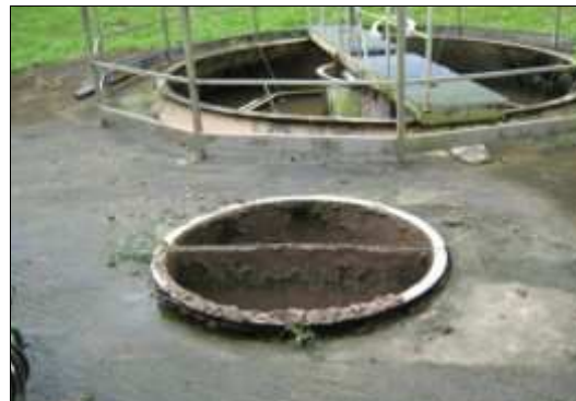
Dégazeur: remontée de boues, pas de mise en sécurité
