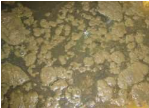
Boues flottantes sur le clarificateur
