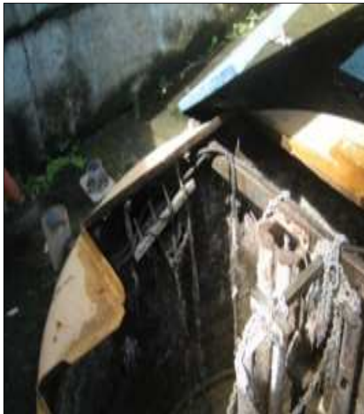
Tres mauvais etat GC, barres de guidage
