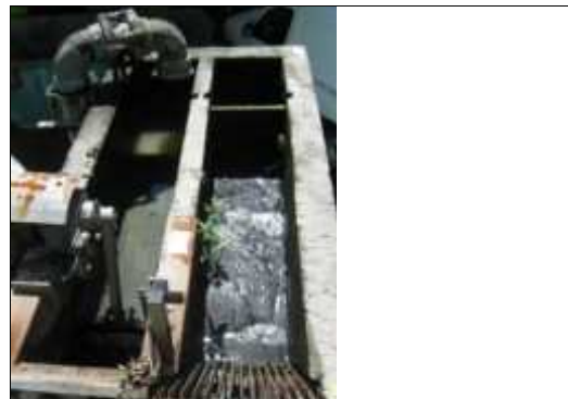
dégrilleur automatique
