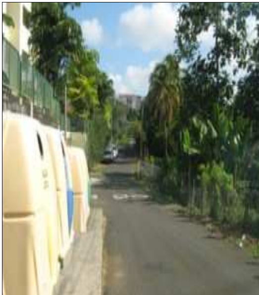
PR sous chaussée
