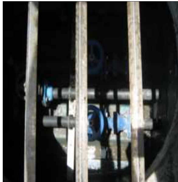
Chambre à vannes
