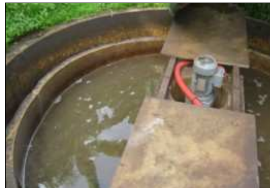
Bassin d'aération et clarificateur combinés
