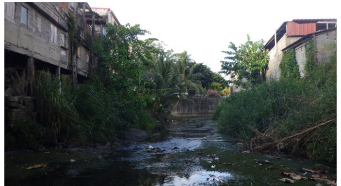
Vue aval de la station
