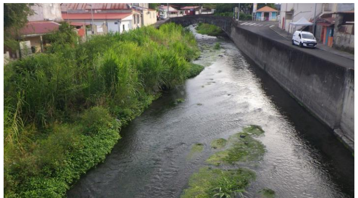
Vue aval de la station
