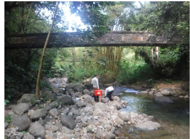
Vue aval de la station
