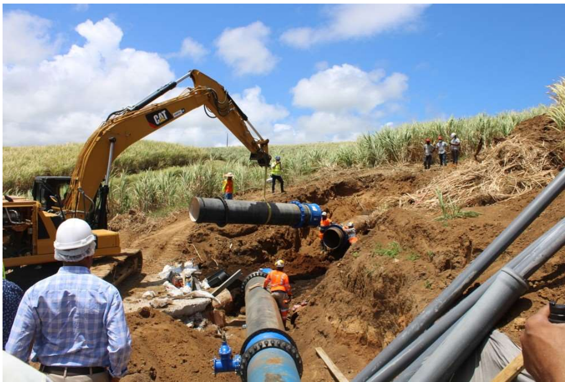
Raccordement de la nouvelle canalisation
