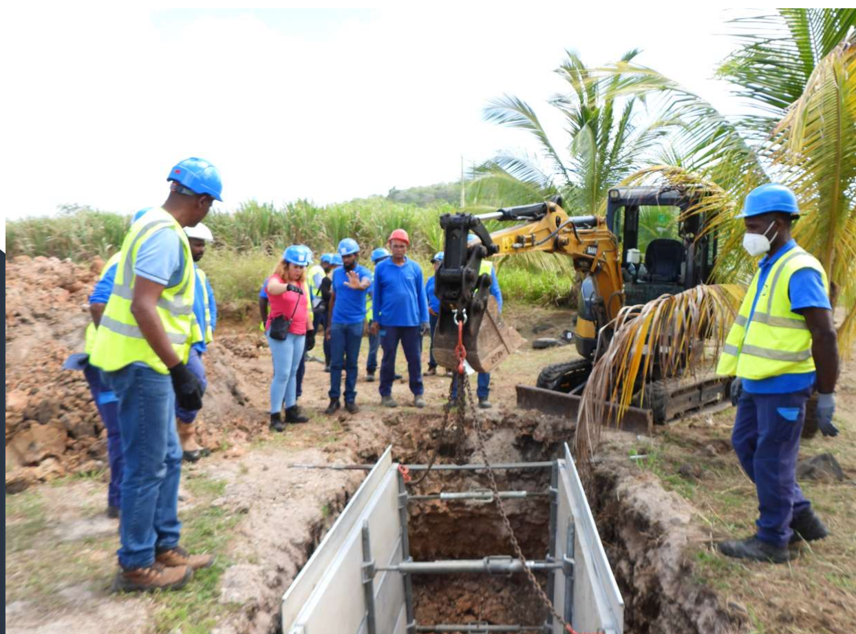
Formation des équipes terrain à la pose de blindages de fouilles
