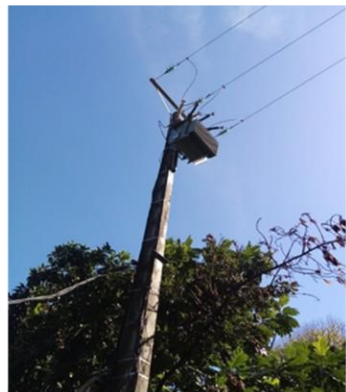
Renouvellement transformateur Four à Chaux au Robert
