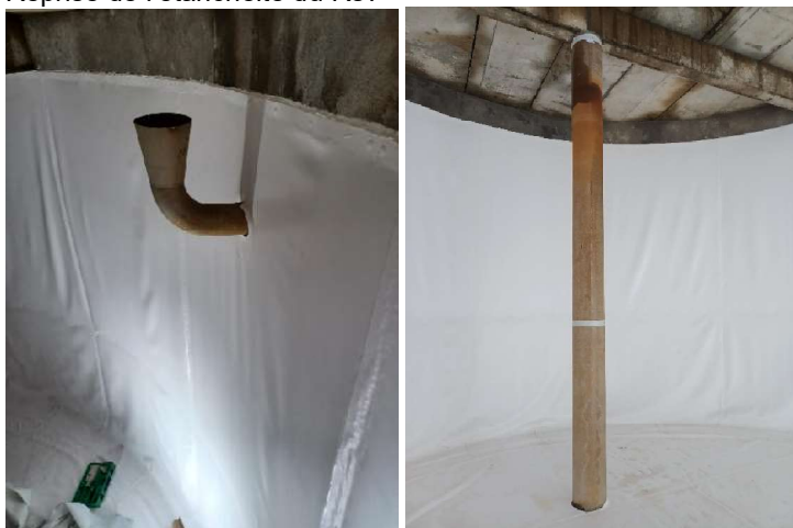
Reprise de l'étanchéité du Rsv
