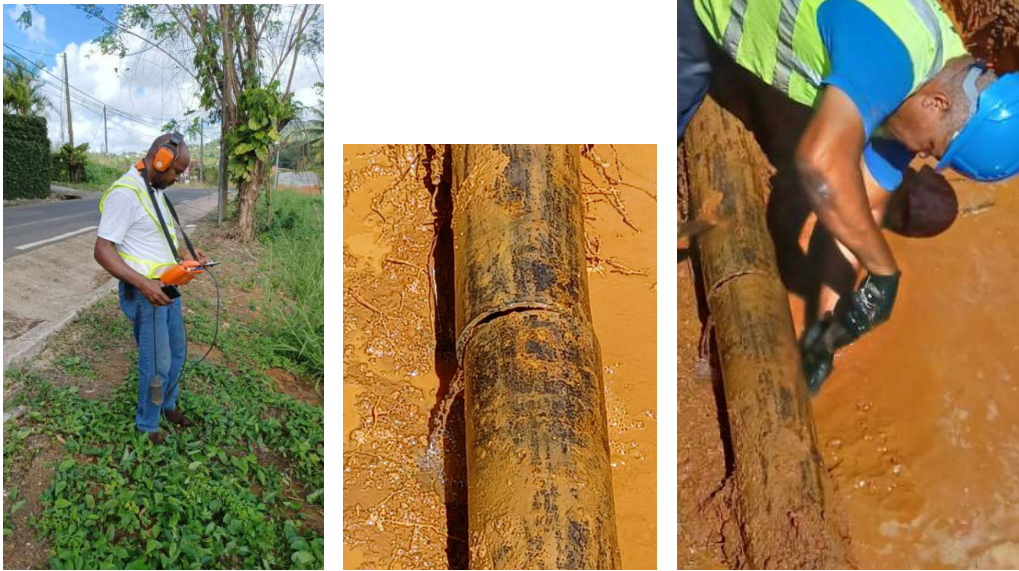
Ecoute pour localisation précise / Terrassement et mise à nu de la casse / Réparation
