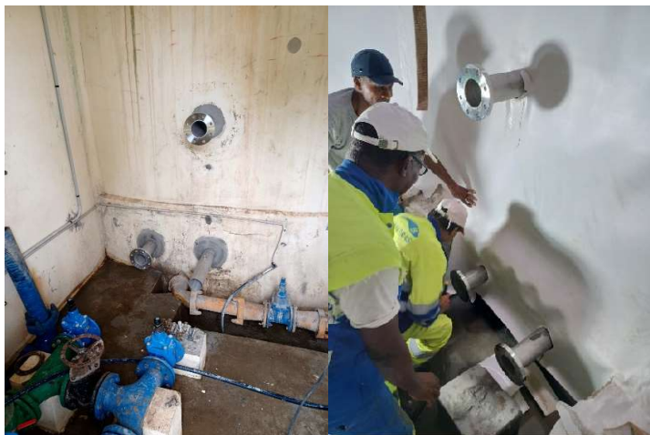
Reprise de l'étanchéité du Rsv
