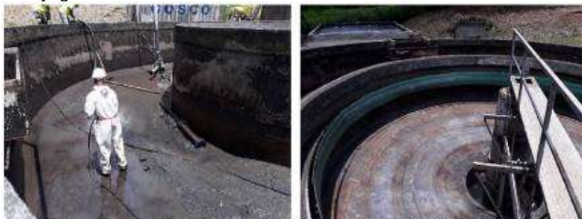
Nettoyage de l'ouvrage existant vidangé par l'exploitant SME (SCE, 14/04/2022)
