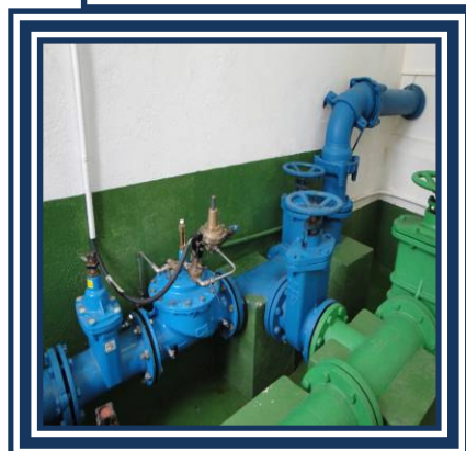
POSE DE VANNE ALTIMETRIQUE RESERVOIR FOND ROUSSEAU
