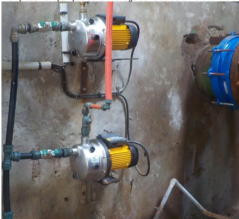
Remplacement pompes échantillonnage usine de traitement du Galion
