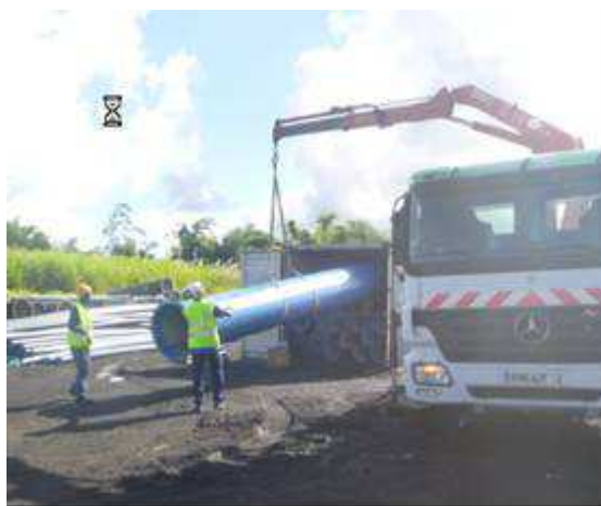
Livraison d'un tuyau en fonte de 800 mm de diamètre pesant plusieurs tonnes.
