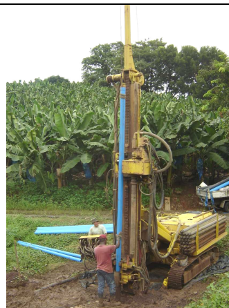
Photo 6 : Mise en place des tubes PVC pleins et crépinés
