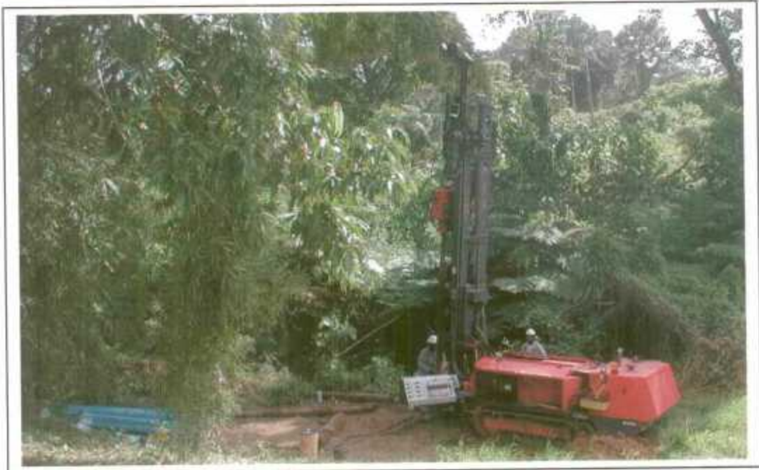
Photo 2 : Photo de la foreuse utilisée par l'entreprise BACHY FONDACO, forage à l'eau et au tricône. Site de Gros Morne.
