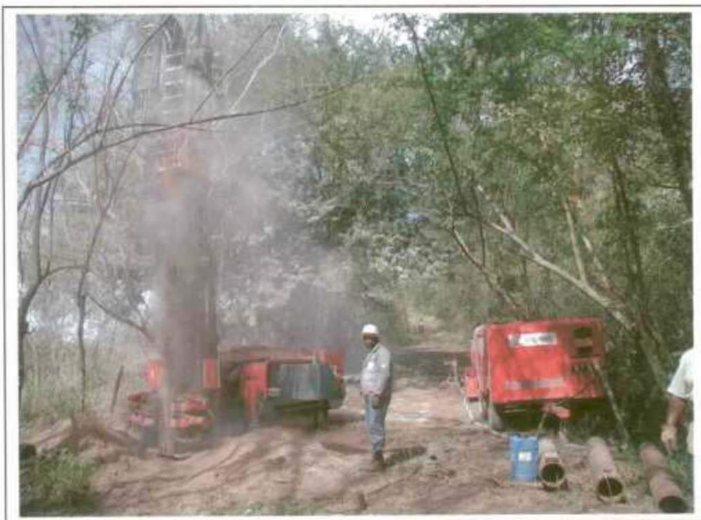
Photo 3 : Photo de la foreuse utilisée par l'entreprise BACHY FONDACO, forage à l'air et au marteau fond de trou. Site du Carbet.
