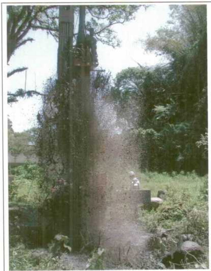
Photo 4 : Photo de la foreuse utilisée par l'entreprise BACHY FONDACO, forage à l'air et au marteau fond de trou. Site de Basse Pointe.
