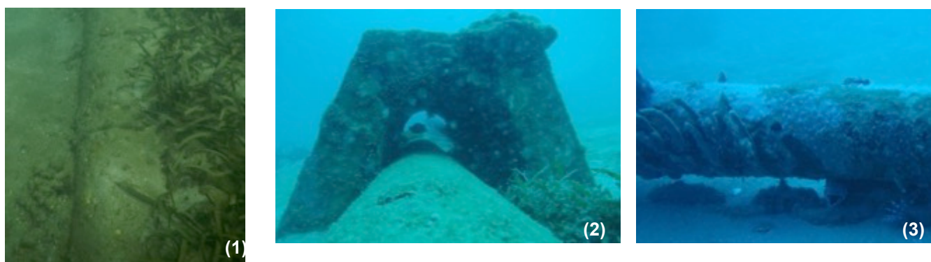
Figure 8 : Particularités notées le long de l'émissaire (1) Colonisation par l'herbier sur un côté - (2) Cavalier large, section profonde – (3) Tuyau ne reposant pas sur le fond, section profonde
