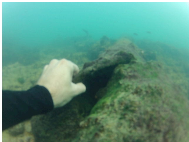
Figure 6 : Illustrations de fuites de l'émissaire de la STEU de Tartane constatées lors du pré-repérage Une cassure importante est observée quelques mètres avant l'extrémité de l'émissaire.
