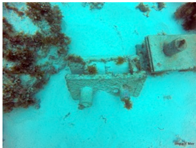
Figure 9 : Bloc béton retourné
