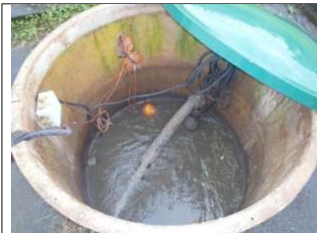
Figure 35 : Le poste de relevage du rejet de la STEU du lotissement « les Oréades » (eaux traitées)
