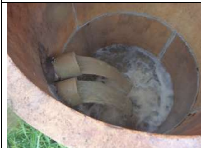
Figure 29 : Un des deux filtres à sable (inutilisé) de la STEU de la cité scolaire Rama
