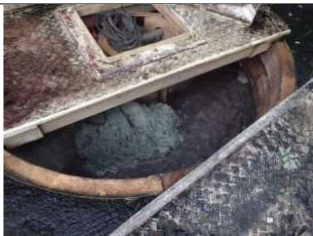
Figure 32 : Le clarificateur de la STEU de la résidence Desmarinières (boues en surface)
