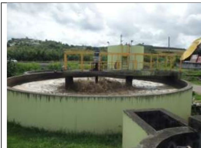
Figure 37 : L'aérateur de la STEU des Côteaux
