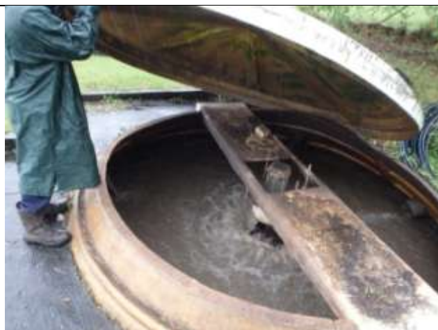
Figure 34 : L'aérateur de la STEU du lotissement « les Oréades »
