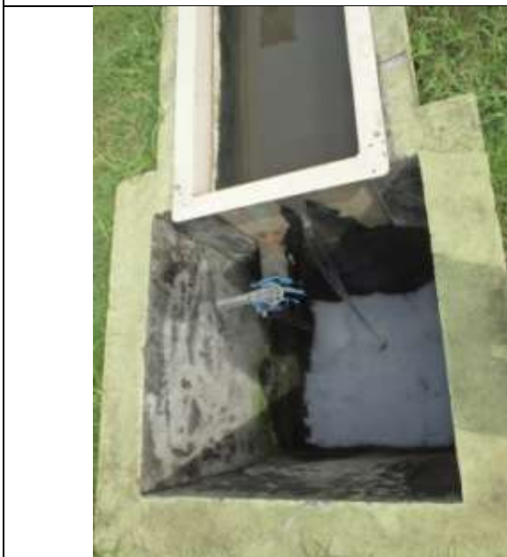
Figure 39 : Le rejet de la STEU des Côteaux (mousse blanche au niveau du rejet)
