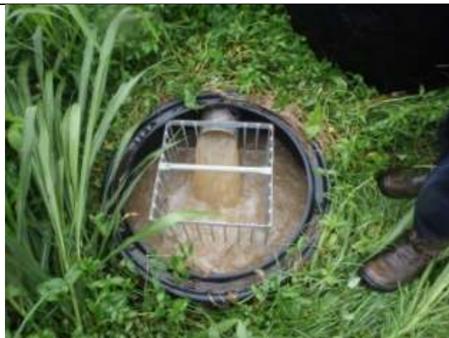
Figure 28 : Le dégrilleur de la STEU de la cité scolaire Rama (on note une forte dilution des eaux brutes)
